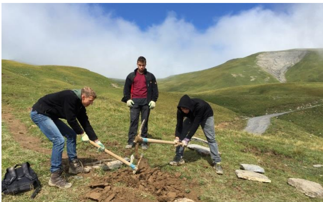
Melchior Burri, Cedric Waser und Joshua Alonso lockern den Boden für neue Wanderwegstufen.
